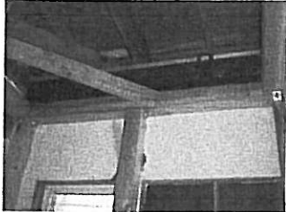
写真10 吊り具(鋼材)設置
