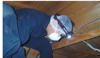
小屋裏の 調査
