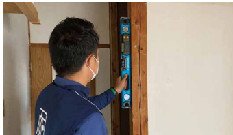
建物の 倒れ確認
